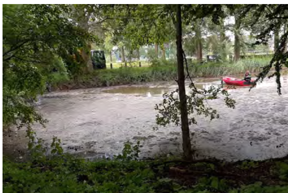
Start van de werkzaamheden schoonmaken vijver bij de Ruitersmolen
