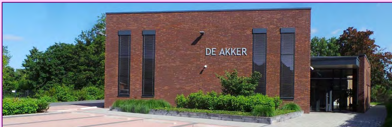
Verenigingsgebouw De Akker van de Gereformeerde Gemeente aan de Ruitersmolenweg.
