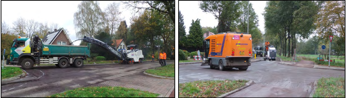
Vanochtend vroeg gingen de wegwerkers al aan de slag op de Arnhemseweg N788, ter hoogte van de "komslinger".
