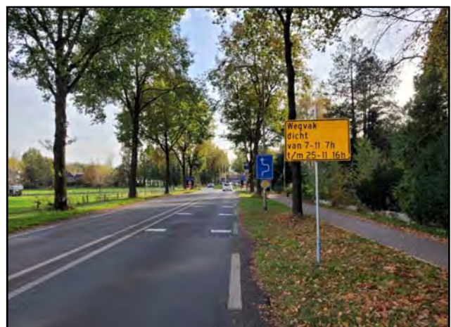
De 'komslinger', door de vorm ook wel 'rugbybal' genoemd wordt aangepakt. Ook wordt de grens van de bebouwde kom iets opgeschoven. De blauwe Beekbergen-borden komen vijftig meter dichter bij Apeldoorn te staan, bij de zijwegen Engelanderskamp en De Els. Zo ontstaat een logischer overgang van 80 naar eerst 50 en daarna 30 kilometer per uur.
