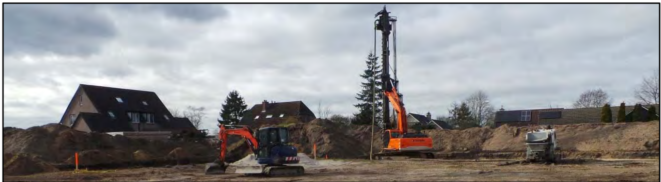
Graafmachines zijn bij het woningbouwproject "Coöperatiehof in Lieren nog druk bezig met het afgraven van de bouwkvavels.
