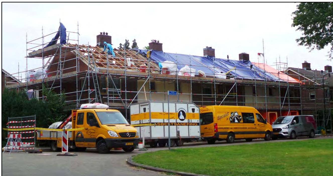
Sinds vorige week is Veluwonen begonnen met het opknappen (o.a. asbestsanering) van de woningen aan het Freule Hartsenplein.
