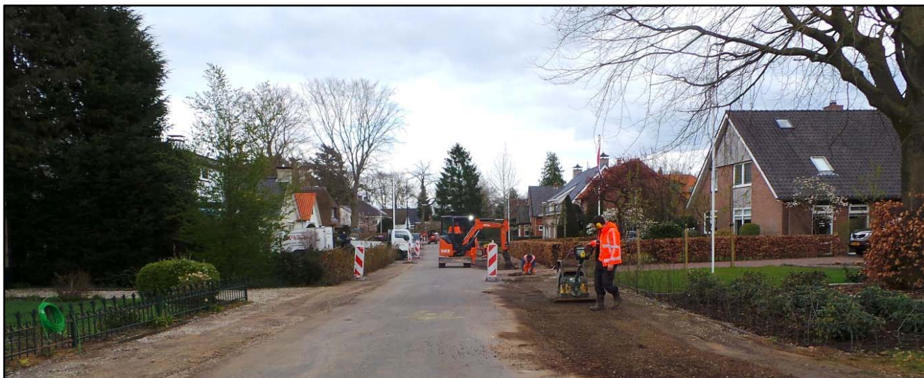
Afgelopen donderdag werd de Hietveldweg in Beekbergen opengebroken voor het aanleggen van glasvezelkabels.
