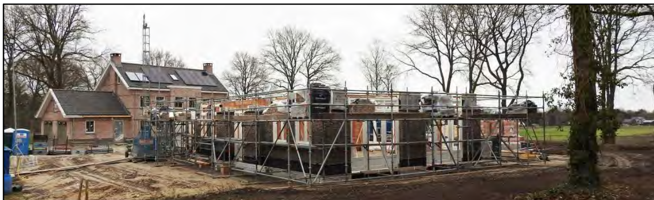
Bouwwerkzaamheden op kavel 6 aan de Leonard Springerlaan is al weken aan de gang.
