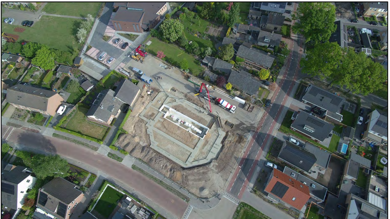
Deze drone-foto werd gemaakt op 8 mei 2020, van de in aanbouw zijnde Eben-Haëzerkerk van de Gereformeerde Gemeente aan de Ruitersmolenweg in Beekbergen.
