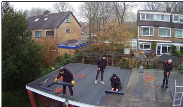
Op het dak van de garages aan de Vlinderstraat is men druk bezig met het vervangen van de bitumen dakbedekking.
