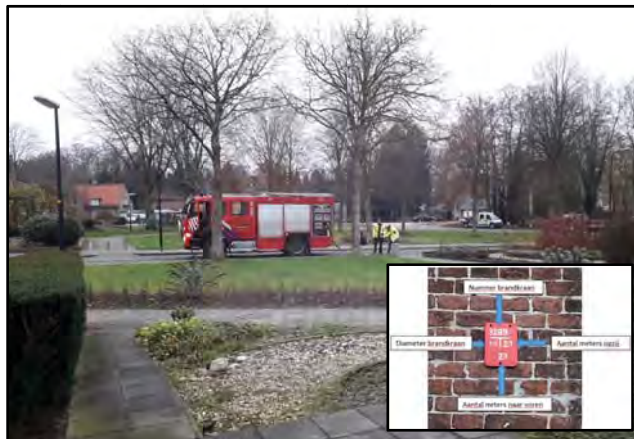
Ieder jaar controleert de brandweer de brandkranen. Brandkranen kunnen op de stoep, in de straat, parkeerplaatsen of openbaar groen zitten. Met behulp van het zogenaamde brandkranenbordje kan je de exacte locatie vinden.
