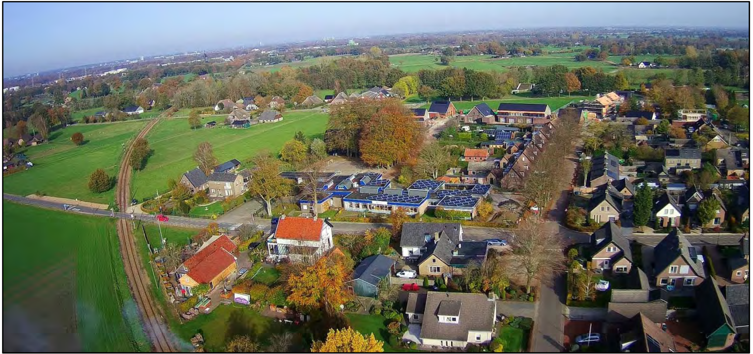
Op deze foto ziet men duidelijk de Prinses Julianaschool met de zonnepanelen en daarachter het nieuwbouwproject "De Beekvallei". Langs het spoor ligt het Theehuis Huize Bloem.
