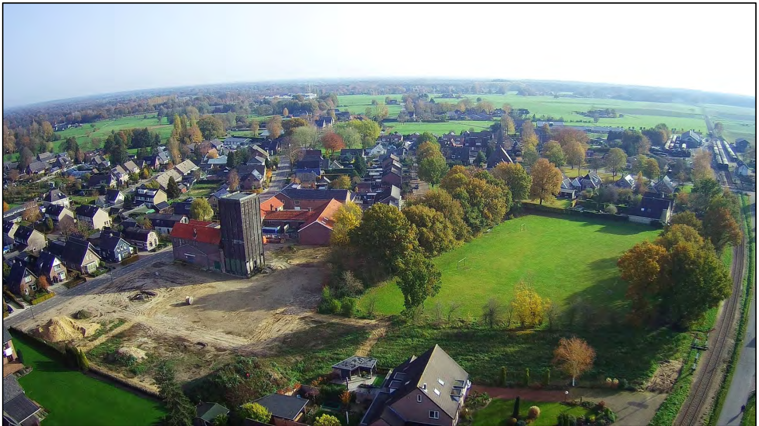
De riolering en de nutsvoorzieningen zijn al aangebracht bij de Cooperatiehof.
