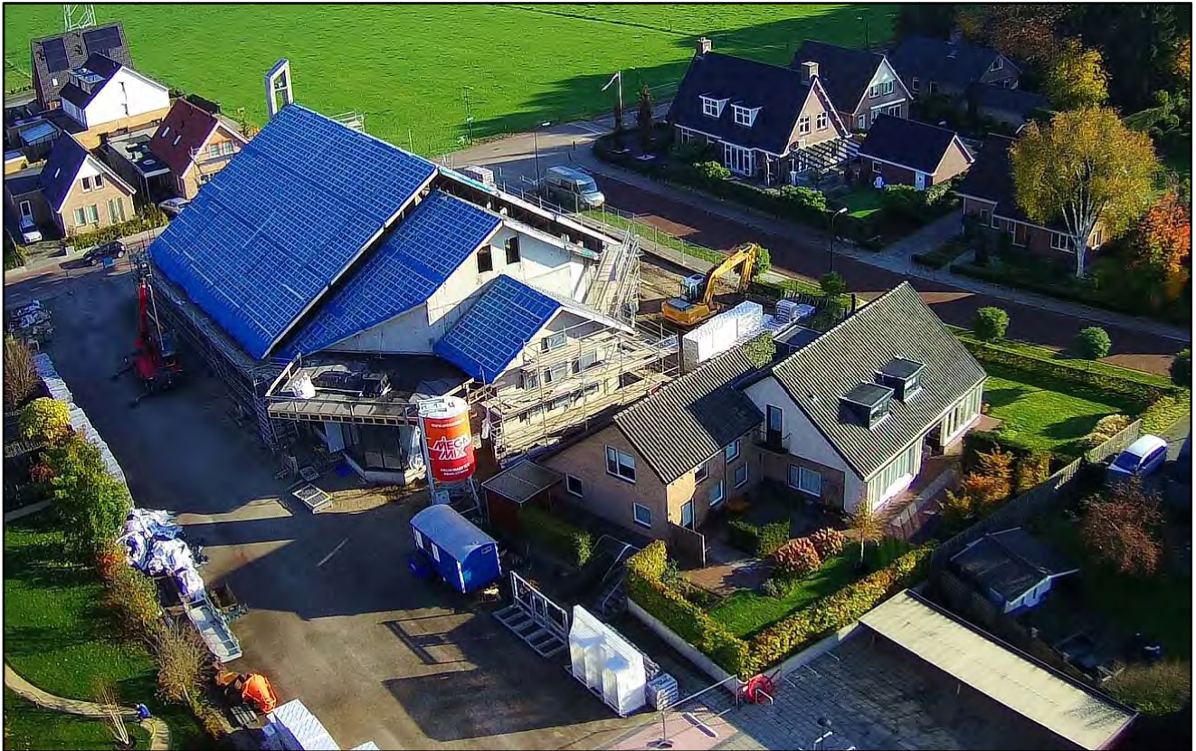
De dakpanelen van de Eben-Haëzer Kerk zijn de afgelopen twee weken erop gezet en de kerkklok heeft ook zijn plek gekregen. Men kan nu verder met de afwerking.
