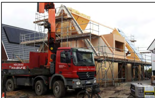
De laatste woning aan De Hoeven in Beekbergen die nog in aanbouw is wordt helemaal opgetrokken uit hout.
