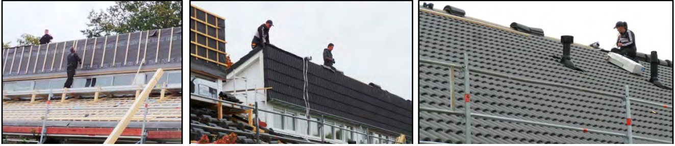
Bij de renovatie van de woningen aan de Waterjufferstraat in Beekbergen wordt het dak stevig aangepakt.
