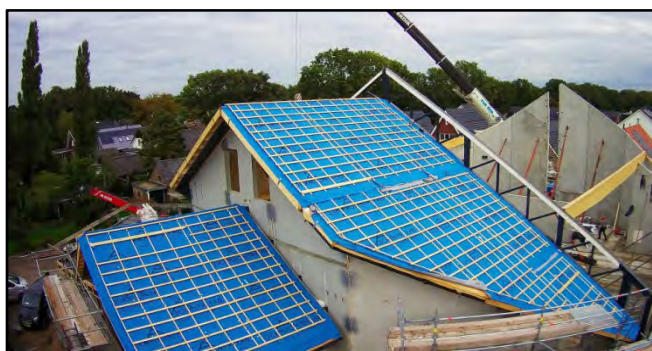
Vorige week zijn de bouwlieden bezig geweest met het plaatsen van de dakelementen van de Eben-Haëzer Kerk van de Gereformeerde Gemeente aan de Ruitersmolenweg in Beekbergen.
