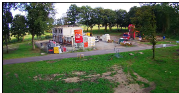
Op bouwkaavel 5 zijn de bouwwerkzaamheden al begonnen.
