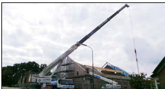
Vorige week zijn de bouwlieden bezig geweest met het plaatsen van de dakelementen van de Eben-Haëzer Kerk van de Gereformeerde Gemeente aan de Ruitersmolenweg in Beekbergen.
