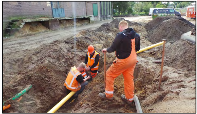
Bij nieuwbouwproject Coöperatiehof in Lieren is men nog wel 2 weken bezig met het aanbrengen van kabels en leidingen voor de nutsvoorzieningen.
