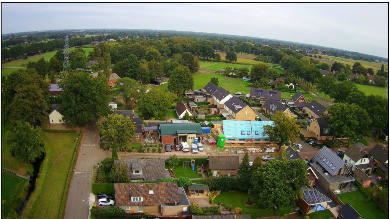
De twee-onder-een-kap woning aan de Ruitersmolenweg in Beekbergen is de laatste woning waar nog aan gewerkt wordt en al bijna in de laatste bouwfase zit.
