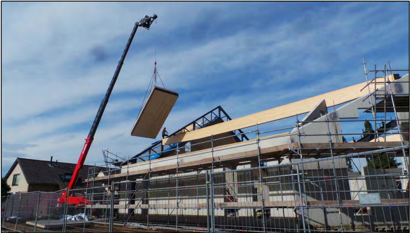
Afgelopen week zijn de bouwlieden bezig geweest met het plaatsen van de dakelementen van de Eben-Haëzer Kerk van de Gereformeerde Gemeente aan de Ruitersmolenweg in Beekbergen.
