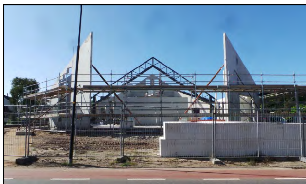
De nieuwbouw van de Eben-Haëzer Kerk van de Gereformeerde Gemeente in Beekbergen krijgt al enige vorm. Afgelopen dagen is men bezig geweest met het plaatsen van de betonnen muurdelen en de dakconstructie.
