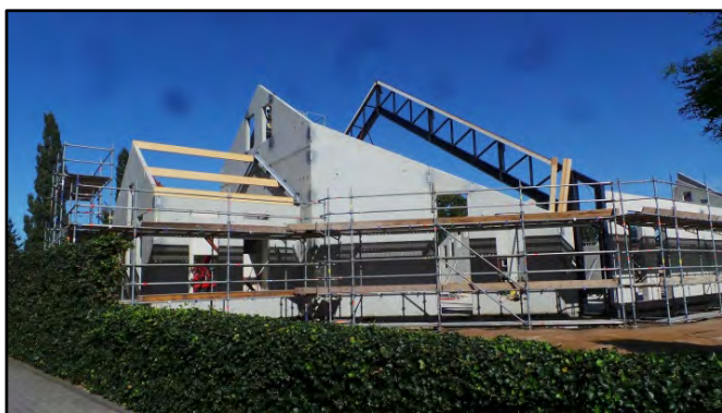
De nieuwbouw van de Eben-Haëzer Kerk van de Gereformeerde Gemeente in Beekbergen krijgt al enige vorm. Afgelopen dagen is men bezig geweest met het plaatsen van de betonnen muurdelen en de dakconstructie.
