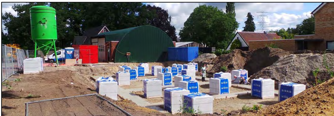
Bij "De Ruiterij" is het beton gestort voor de bouw van de laatste twee woningen, twee-onder-één-kap, op de hoek Ruitermolenweg/Kolffweg in Beekbergen.
