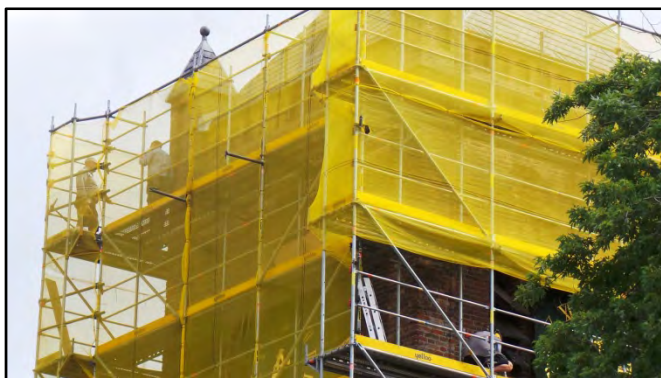
De bouwvakkers zijn nog wel even bezig met onderhoud aan het voegwerk van de Dorpskerk in Beekbergen.
