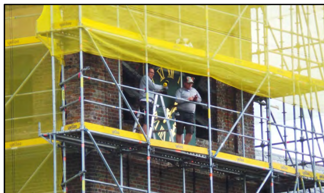
De bouwvakkers zijn nog wel even bezig met onderhoud aan het voegwerk van de Dorpskerk in Beekbergen.
