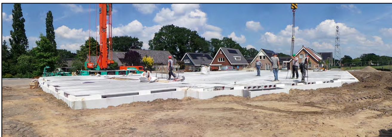
Op de laatste foto wordt de laatste betonnen vloerdeel geplaatst.
