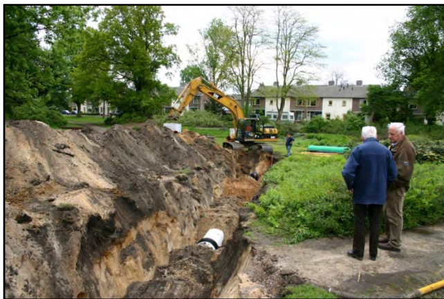
Medio mei 2010 werd er gewerkt aan de infiltratieleiding (wadi)* in het Freule Hartsen Plantsoen.
