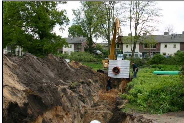
Medio mei 2010 werd er gewerkt aan de infiltratieleiding (wadi)* in het Freule Hartsen Plantsoen.
