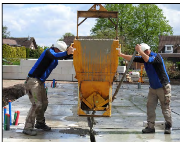
Vorige week is Nikkels Bouw verder gegaan met het storten van beton en het aanleggen van de sanitaire leidingen. Foto's John Tanasale
