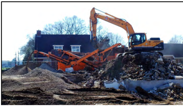
De sloopklus is bijna geklaard. Alle puin is door de mobiele puinbreker verwerkt tot puingranulaat en daarna afgevoerd. Foto's John Tanasale
