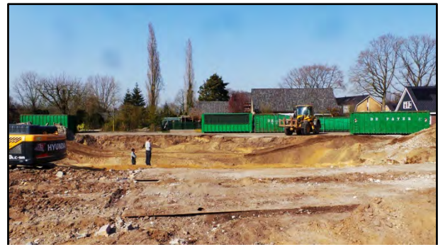
De sloopklus is bijna geklaard. Alle puin is door de mobiele puinbreker verwerkt tot puingranulaat en daarna afgevoerd. Foto's John Tanasale
