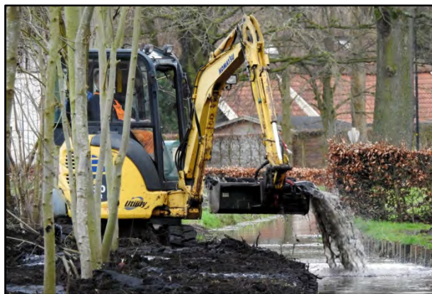
De Oude Beek langs de Tullekensmolenweg, tussen het Ford Museum en de Kruisweg, wordt geschoond en uitgediept in opdracht van Waterschap Vallei & Veluwe. Oktober vorig jaar was er al een begin gemaakt, maar wordt deze maand afgerond. (foto's John Tanasale)
