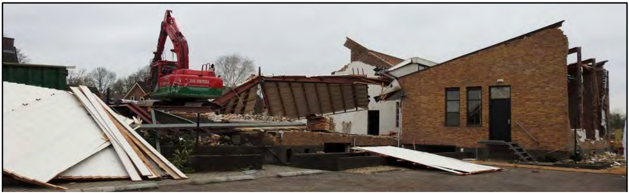
De sloop van de Eben-Haëzerkerk in Beekbergen vordert snel.
