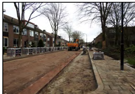
Op de twee foto's links worden voorbereidingen getroffen voor het aanleggen van de wadi (Water Afvoer Drainage Infiltratie). Op de rechter foto gaat maandag 24 februari de "tapijstenenlegger-machine" zijn kunsten vertonen.
