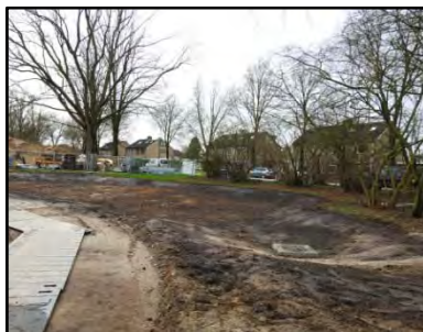
Op de twee foto's links worden voorbereidingen getroffen voor het aanleggen van de wadi (Water Afvoer Drainage Infiltratie). Op de rechter foto gaat maandag 24 februari de "tapijstenenlegger-machine" zijn kunsten vertonen.
