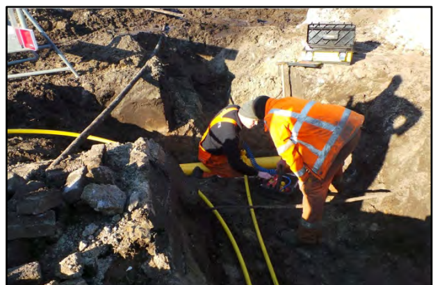
Aan de Veldbrugweg in Lieren worden de gasleidingen aangelegd.
