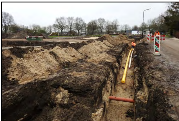
Aan de Veldbrugweg in Lieren worden de gasleidingen aangelegd.
