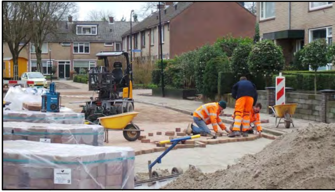
Aan de Keizersmantel is men begonnen met de bestrating.
