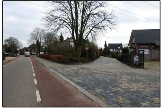
De aansluiting Achterste Kerkweg naar de Dorpstraat is voltooid.
