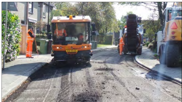
Vorige week is men ook begonnen met het freeze van het wegdek aan de Koningspage. Bij de Keizersmantel, vanaf de Ruitersmolenweg zijn ze al begonnen met het leggen van de straatklinkers.
