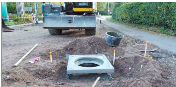
Bij de Loenenseweg, vanaf de Koningsweg, werd de oude riolering vervangen.
