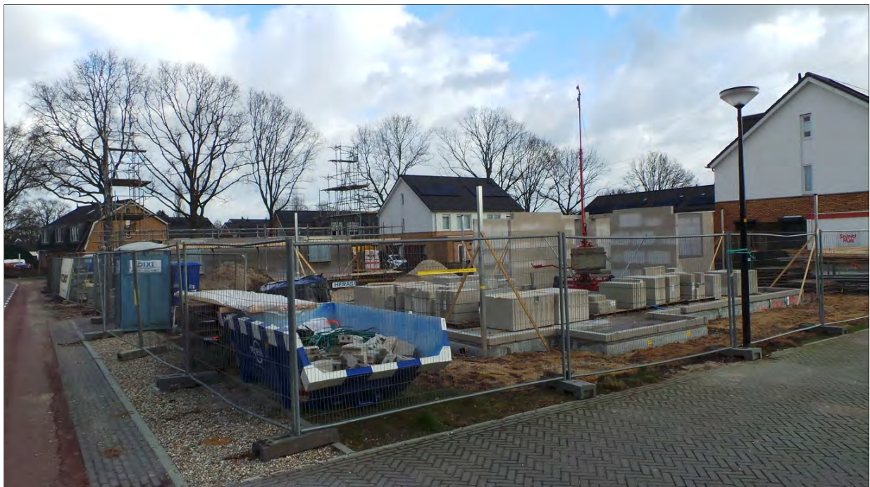
De bouw op de kavels tegenover de Eben-Haëzer Kerk aan de Tullekensmolenweg begint al enige vorm te krijgen.
