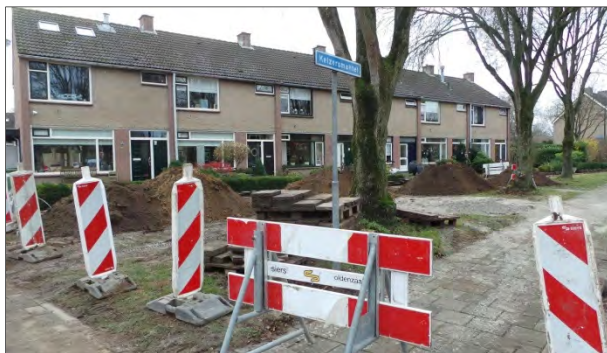
Bij de Keizersmantel wordt de verzamelleiding van de riolering bij het woonblok vervangen.
