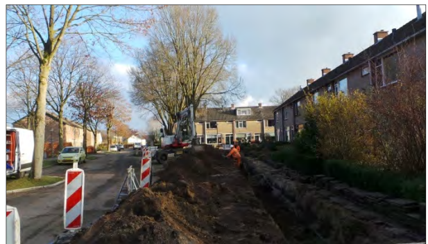
Bij de Keizersmantel wordt de verzamelleiding van de riolering bij het woonblok vervangen.
