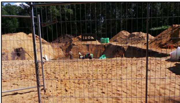
Nieuwbouw begonnen op terrein voormalige Katholieke Kerk aan de Henk Vulinkweg.
